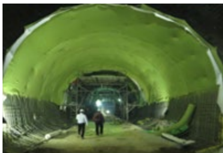
شکل ۱۸: آماده سازی سطح داخلی تونل و اجرای عایق
