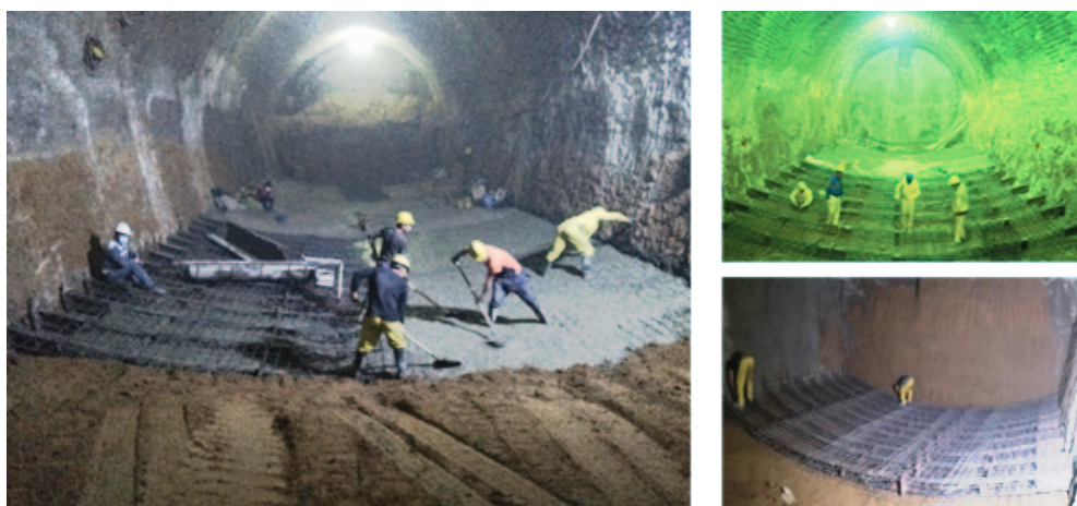
شکل ۱۷: اجرای کف بند دائم در تونل اصلی
