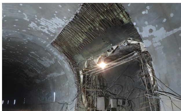
شکل ۱۳: فرآیند اجرای شمع و تیر در محل اتصال تونل دسترسی به تونل اصلی
