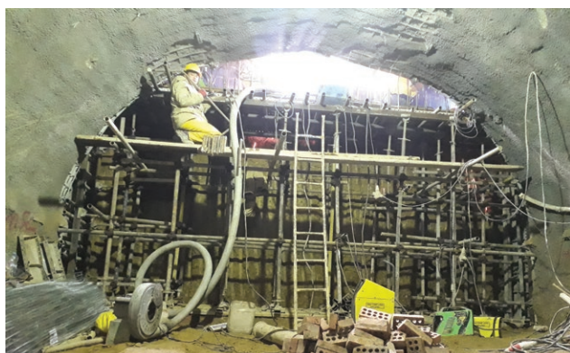
شکل ۱۲: فرآیند اجرای شمع و تیر در محل اتصال تونل دسترسی به تونل اصلی
