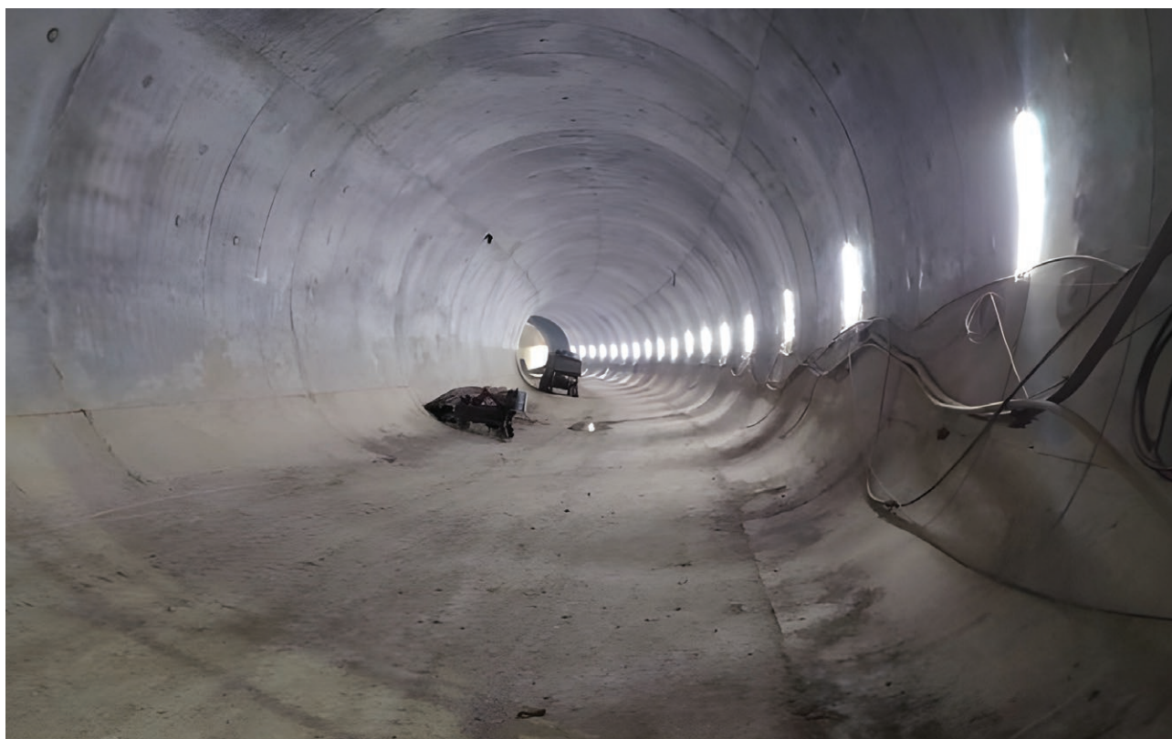
شکل ۲۱: نمایی از تونل اتریشی پس از پوشش نهایی
