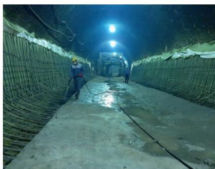
شکل ۱۹: آرماتوربندی، قالببندی و بتن ریزی فونداسیون
