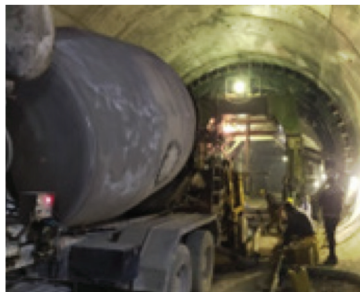
بتن ریزی دیواره و سقف سازه اصلی شکل ۲۰: آرماتوربندی و بتن ریزی کل تونل
