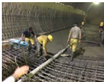
شکل ۱۹: آرماتوربندی، قالببندی و بتن ریزی فونداسیون
