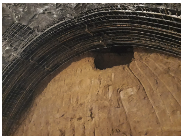
شکل ۸: عبور تونل متروی اسلامشهر از زیر چاه‌ها و حفرات ناشناخته
