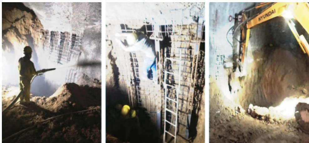
شکل ۱۶: توالی حفاری تونل اصلی و اجرای تحکیمات موقت
