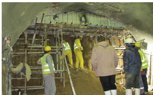
شکل ۱۲: فرآیند اجرای شمع و تیر در محل اتصال تونل دسترسی به تونل اصلی
