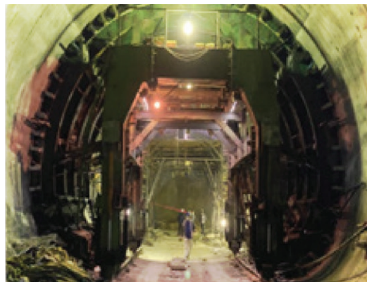
فیکس کردن قالب یکپارچه دیواره و سقف سازه تونل و سربندی قالب
