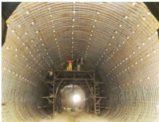
آرماتوربندی دیواره و سقف سازه تونل
