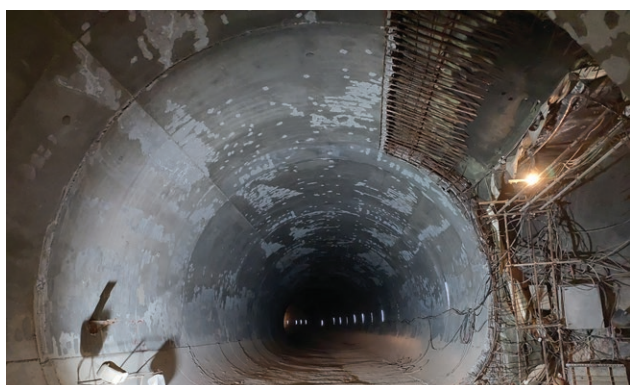
شکل ۱۳: فرآیند اجرای شمع و تیر در محل اتصال تونل دسترسی به تونل اصلی
