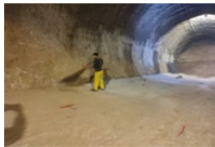
شکل ۱۸: آماده سازی سطح داخلی تونل و اجرای عایق
