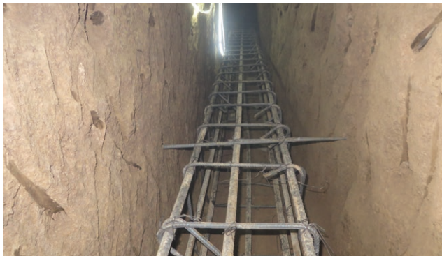
شکل ۱۴: اجرای تیر پیشرو در تونل اصلی
