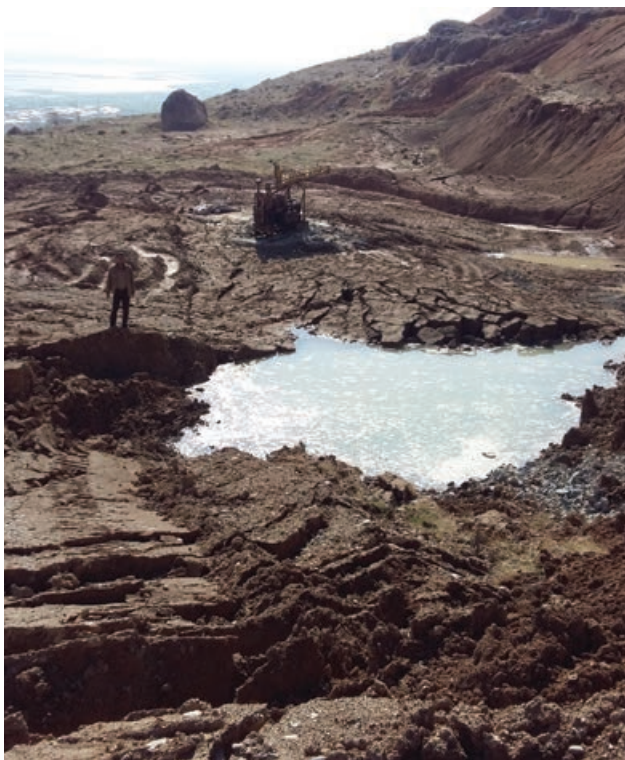
شکل ۴: زمین لغزش رخ داده در محدوده کیلومتر ۴۰
