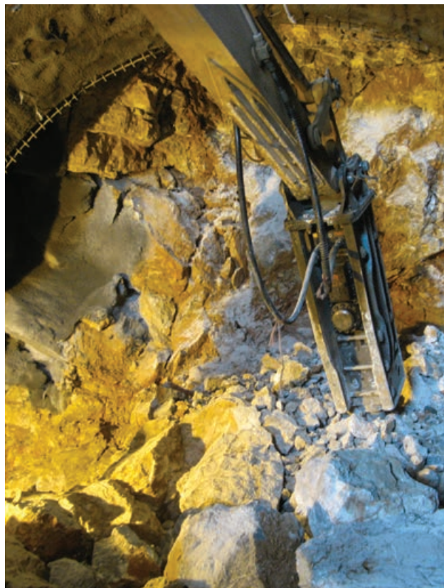
شکل ۱۰: برخورد به مناطق گسل خورده و بلوک‌های ناپایدار
