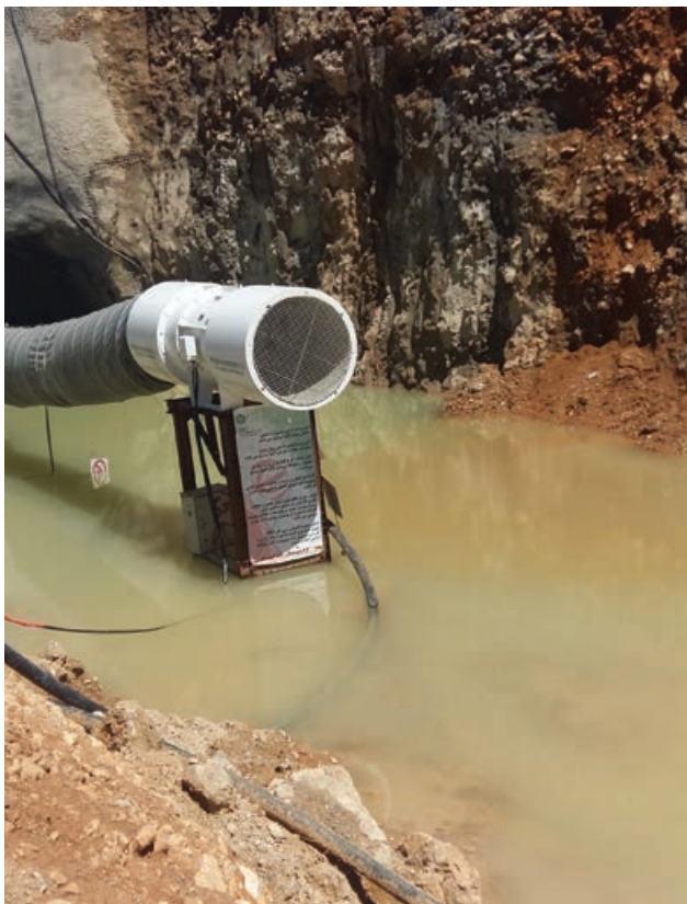
شکل ۱۱: هجوم آب زیرزمینی در تونل کیلومتر ۸۰
