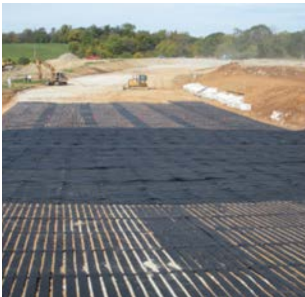
شکل ۳: تقویت خاکریز با ژئوگریدها
