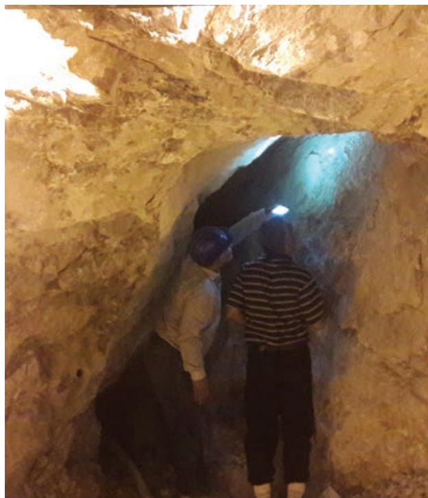
شکل ۱۲: برخورد به حفره کارستی در تونل کیلومتر ۷۸
