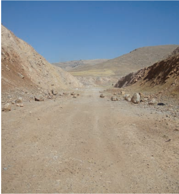
شکل ۲: سقوط سنگ
