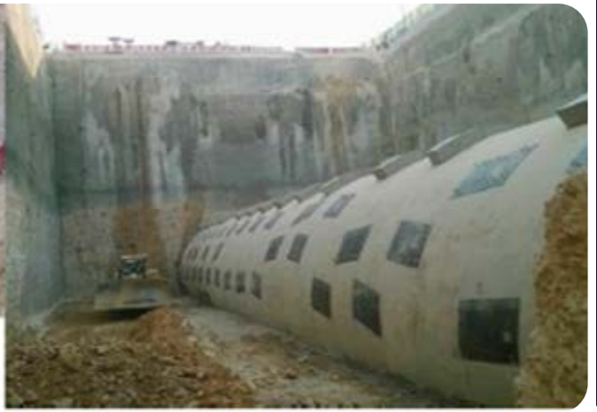
● شکل شماره ۳ - تاج تونل و خاکبرداری پیرامون تونل و مقاوم سازی درزها
