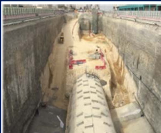
● شکل شماره ۴ - دال زیرین و سازه داخلی ایستگاه
