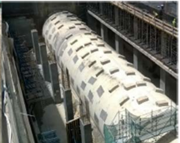
● شکل شماره ۴ - دال زیرین و سازه داخلی ایستگاه
